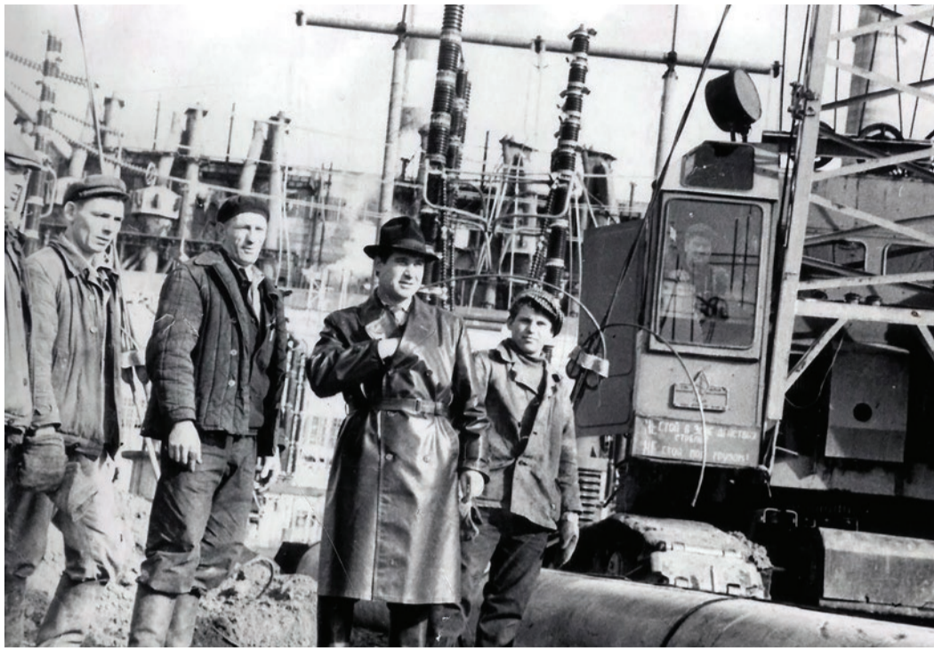
На стройплощадке Троицкой ГРЭС
